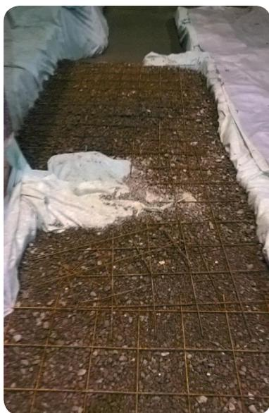
**La ghiaia di cava e la rete elettrosaldata per la formazione del successivo massetto.**
