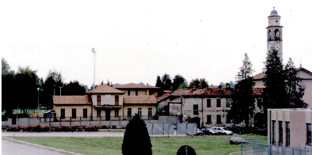
L'asilo nella foto risale agli anni '50 del secolo scorso. Rispetto alla costruzione originaria è stato aggiunto il sopralzo al centro richiesto dalle suore come piccola cappella interna. La parte di sinistra era il salone con i banchi per i bambini. Davanti all'edificio vi erano alcuni alberi (tigli?) mentre la parte posteriore era il cortile per le attività all'aperto.
