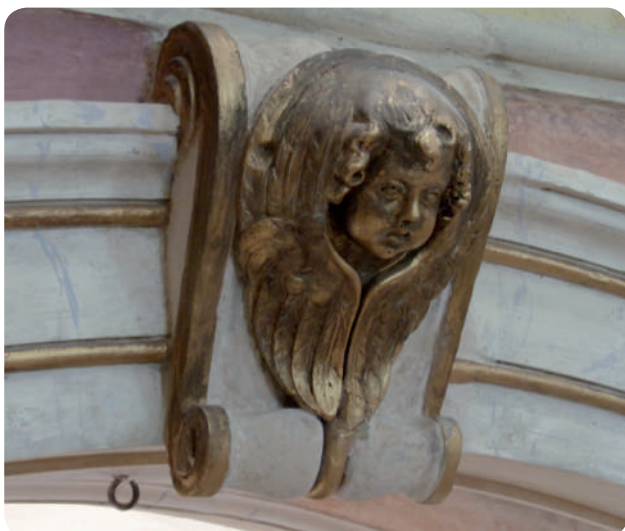
Decorazione archi navata centrale
