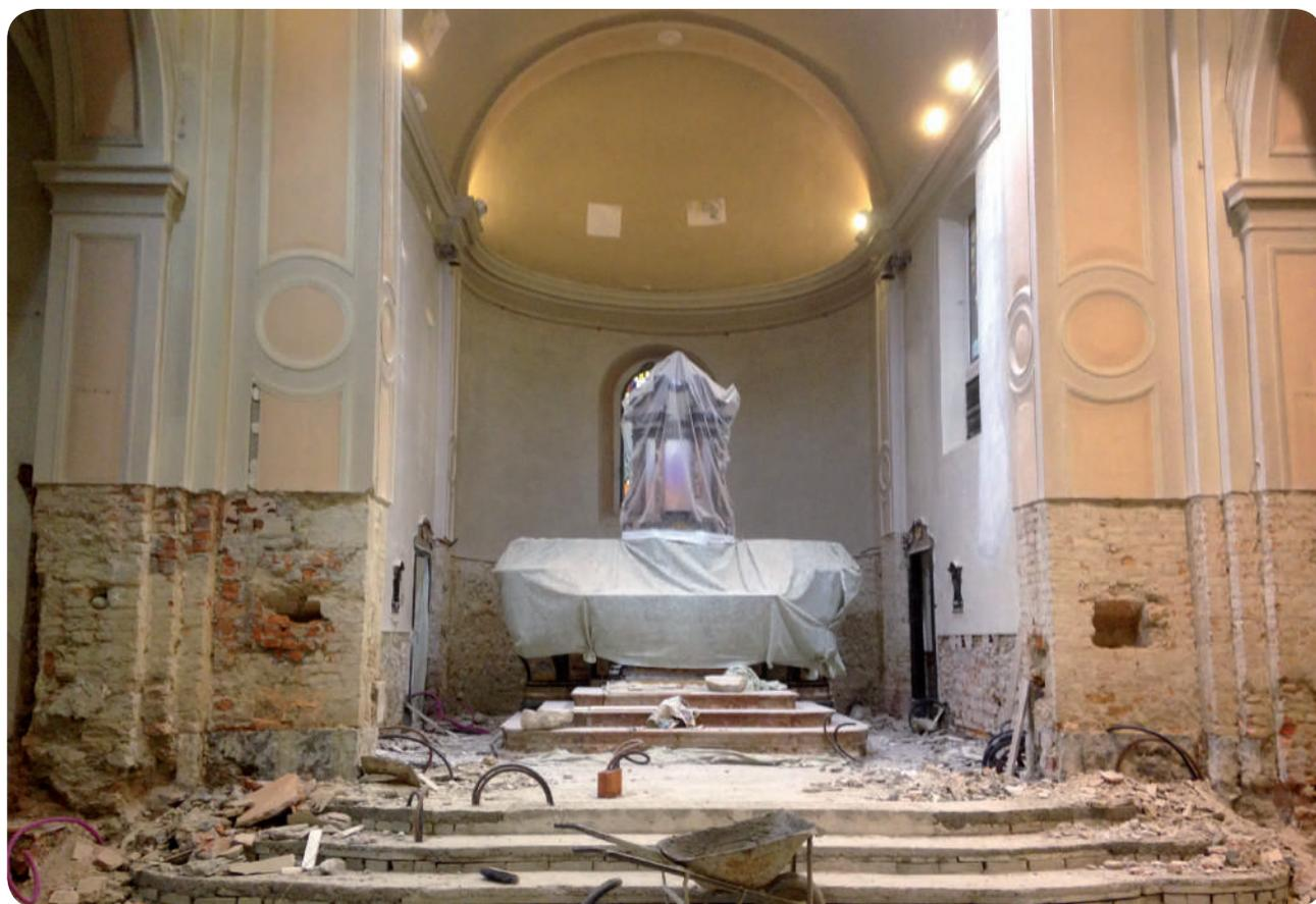
tetti con teli speciali e ricoperti con adeguato materiale inerte prima dell'esecuzione delle opere di realizzazione del sottofondo per la nuova pavimentazione, consistenti nella posa in successione di lastre prefabbricate, di rete elettrosaldata e di finale gettata di calcestruzzo.
